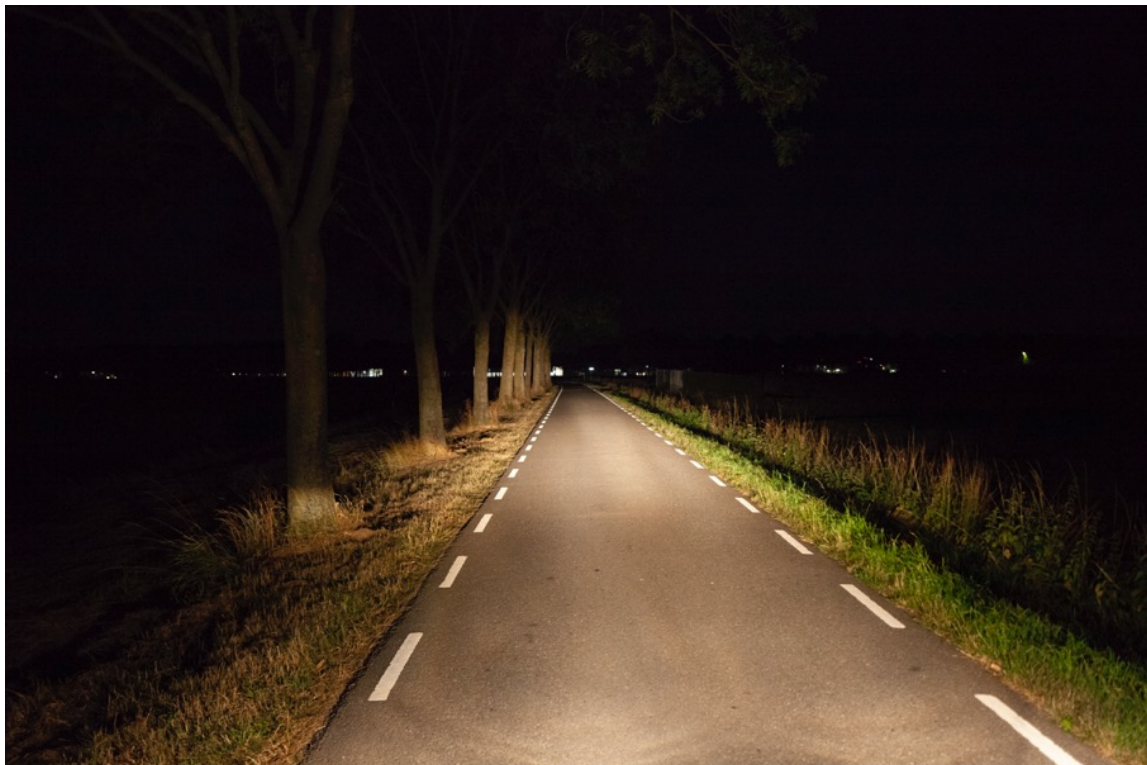
Foto: Oude Beesdseweg, reflecterende strepen geven het verloop van de weg goed weer.
