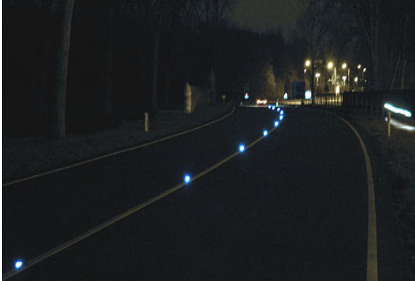
Foto: ledlampjes in de as van de weg elders in het land.
