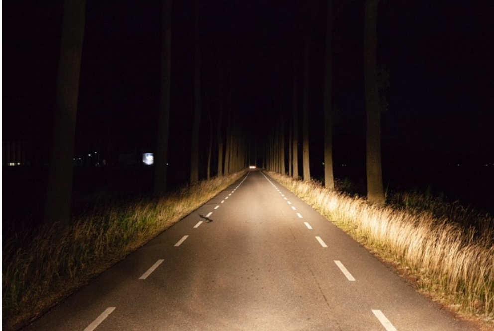
Foto: Korte Avontuurseweg, schrikhek aan het einde van de weg is van veraf duidelijk zichtbaar.
