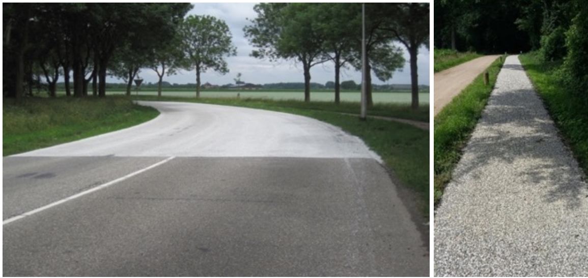
Foto: Een stuk wegdek en een fietspad elders in het land voorzien van een witte toplaag.
